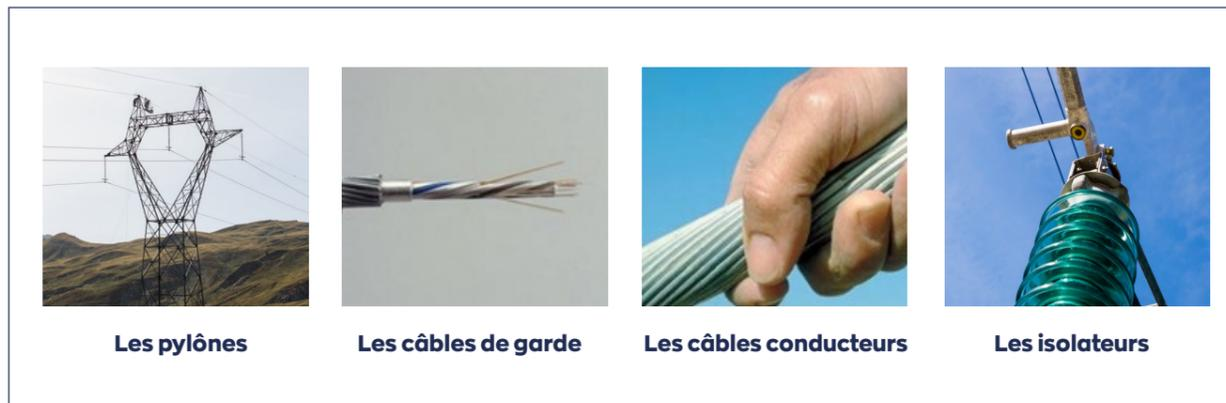
Figure 28 - Photos des composants d'une ligne aérienne
